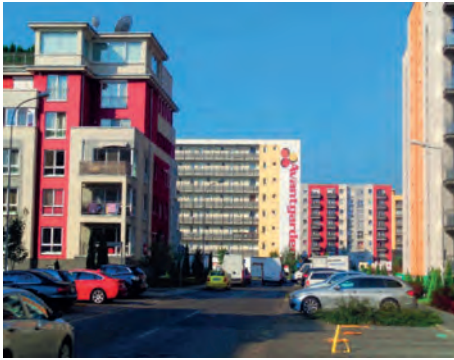
Abb.II.7.5 Neue Eigentumswohnungen am Stadtrand von Braşov/Kronstadt
